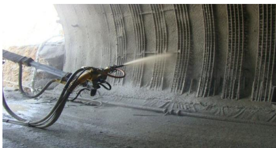
شکل ۴. نمایی از استفاده تری دی پانل سازه‌ای در احداث لاینینگ تونل‌ها
