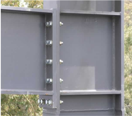
شکل ۱. اتصال تیر به ستون با استفاده از صفحه انتهایی و پیچ [۲]
